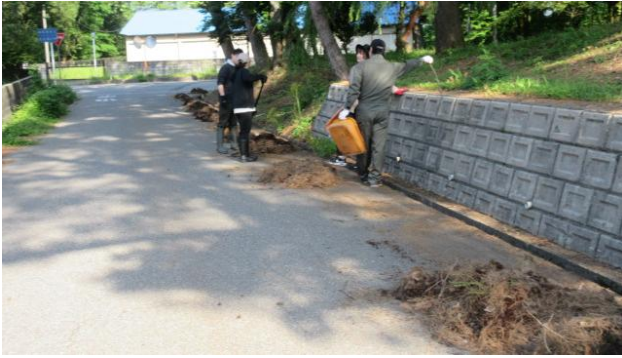
↑ 側溝の清掃の様子です。
